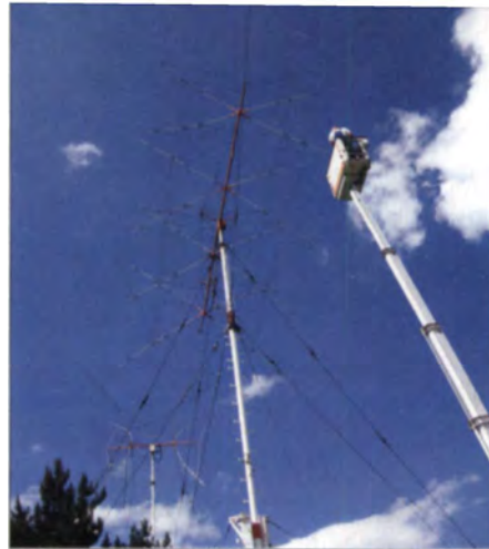
Reparatur einer 4-Element-Quad mit Hubsteiger
